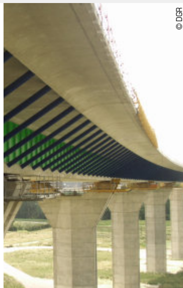
> Viaduc de Meaux
